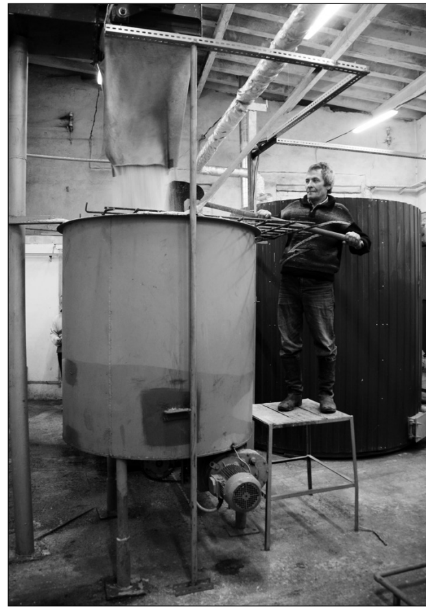
В деповской котельной установили оборудование, работающее на местных видах топлива.
